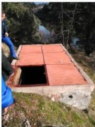
Figura 2.- Arqueta existente en PK 0+000 y zona de bajada de la tubería hasta el canal de descarga
